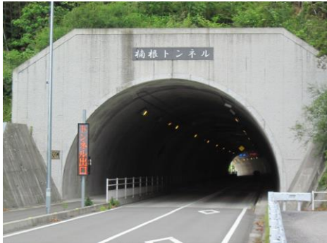
阿南市 楠根トンネル
