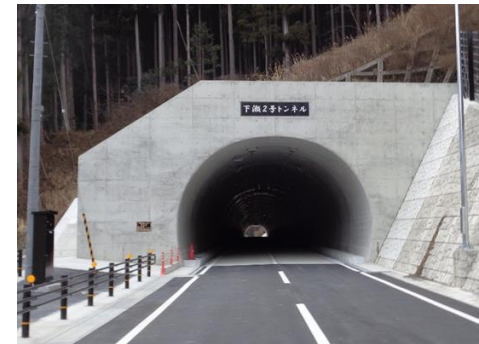
三好市 下瀬2号トンネル
